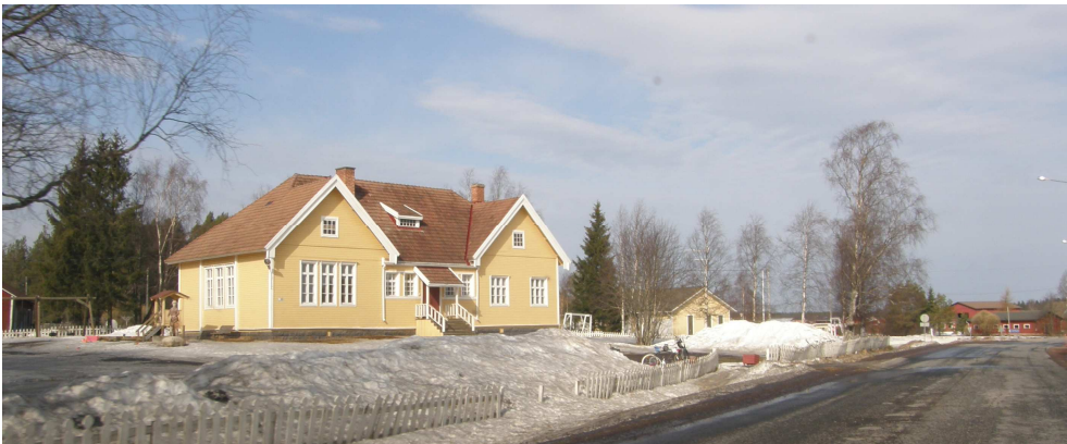
Kuva 20. Taluskylän koulun vanha puoli on rakennettu vuonna 1916.
