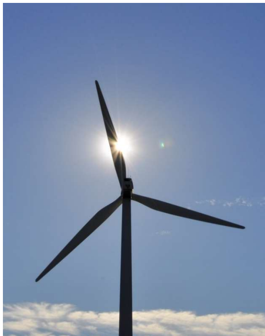
Kuva 49. Tuulivoimaloiden lavat aiheuttavat pyöriessään vilkkumista ja varjon välkkymistä aurinkoisella säällä.
