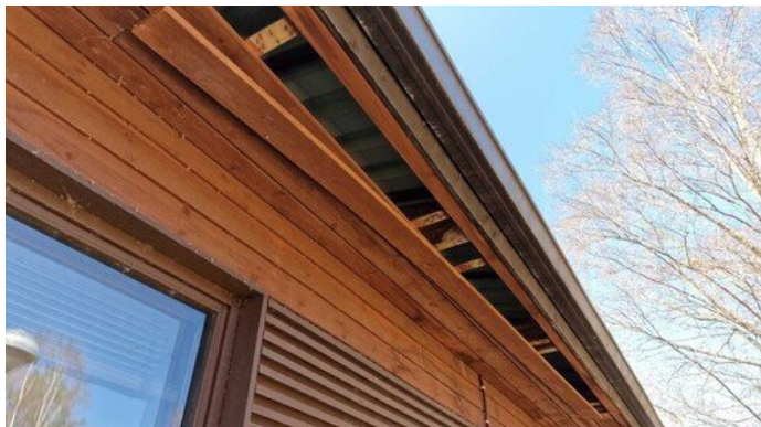
Kuva 19 (Kts. pohjakuvan 1, Alavieskan vanhustenkoti merkintä 19.)
