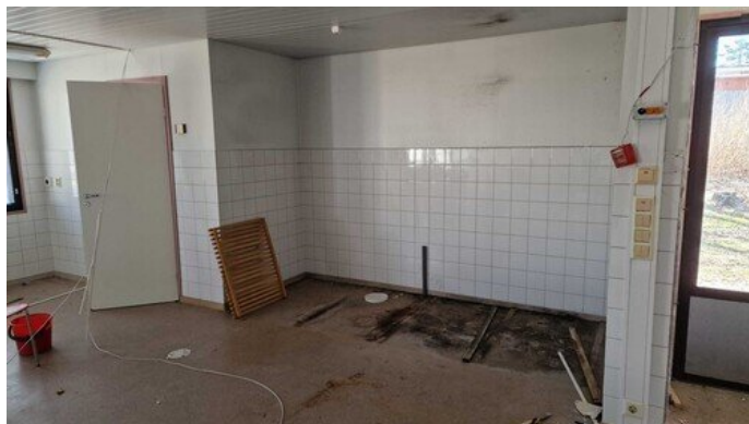
Kuva 4 (Kts. pohjakuvan 1, Alavieskan vanhustenkoti merkintä 4.)
