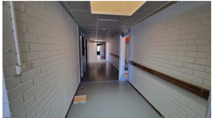
Kuva 18 (Kts. pohjakuvan 1, Alavieskan vanhustenkoti merkintä 18.)
