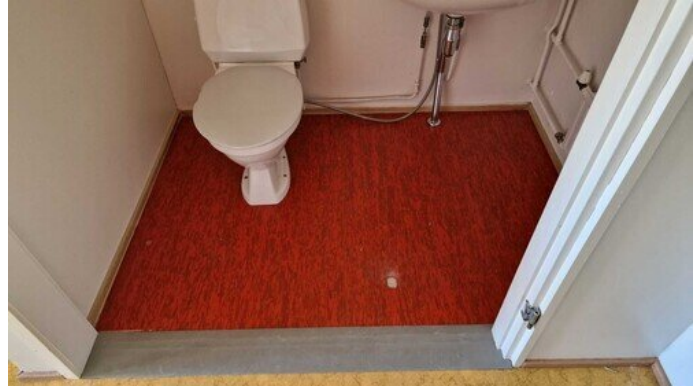
Kuva 14 (Kts. pohjakuvan 1, Alavieskan vanhustenkoti merkintä 14.)
