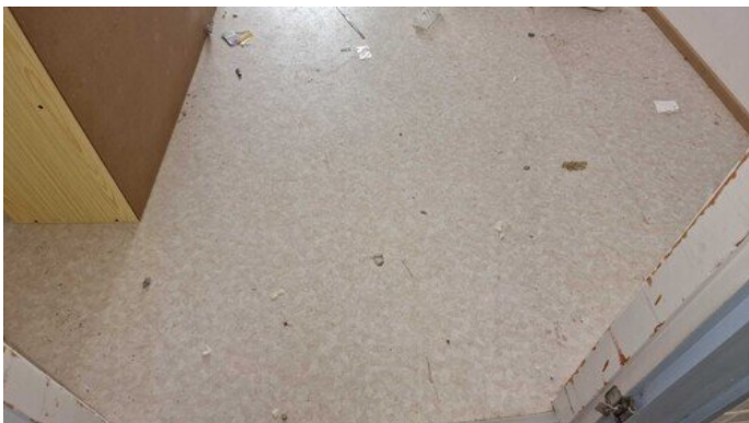
Kuva 9 (Kts. pohjakuvan 1, Alavieskan vanhustenkoti merkintä 9.)
