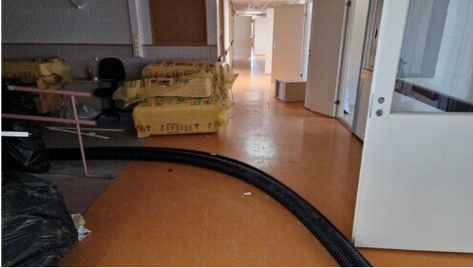
Kuva 13 (Kts. pohjakuvan 1, Alavieskan vanhustenkoti merkintä 13.)
