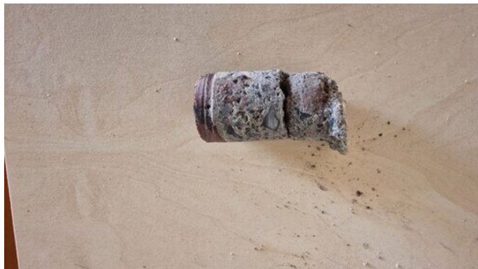
Kuva 20 Poranäyte pesuhuoneen lattiasta.
